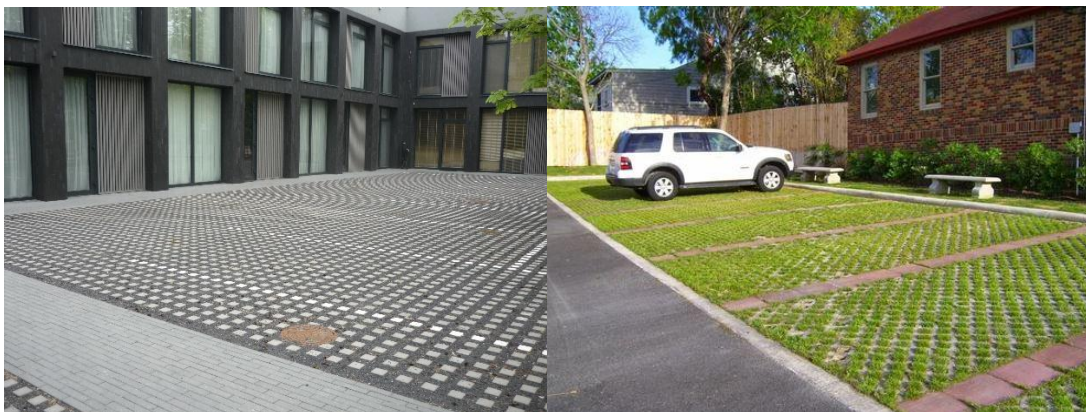
15 av. Analogai: laidžių dangų, ažūrinių betono aikštelių automobilių stovėjimo aikštelė
