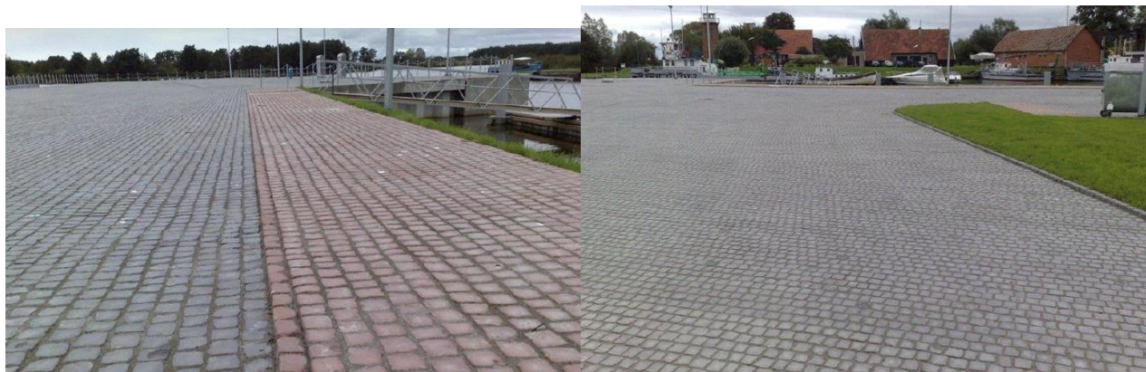
37 pav. vandeniui laidaus grindinio pavyzdžiai.
