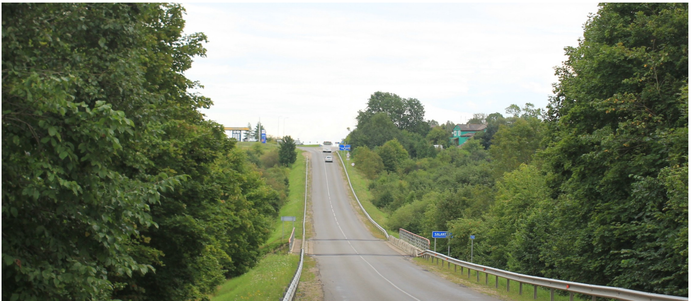
1.1.3 pav. Salanto upės slėnis nuo Mosėdžio pusės krašto kelyje Nr. 169
