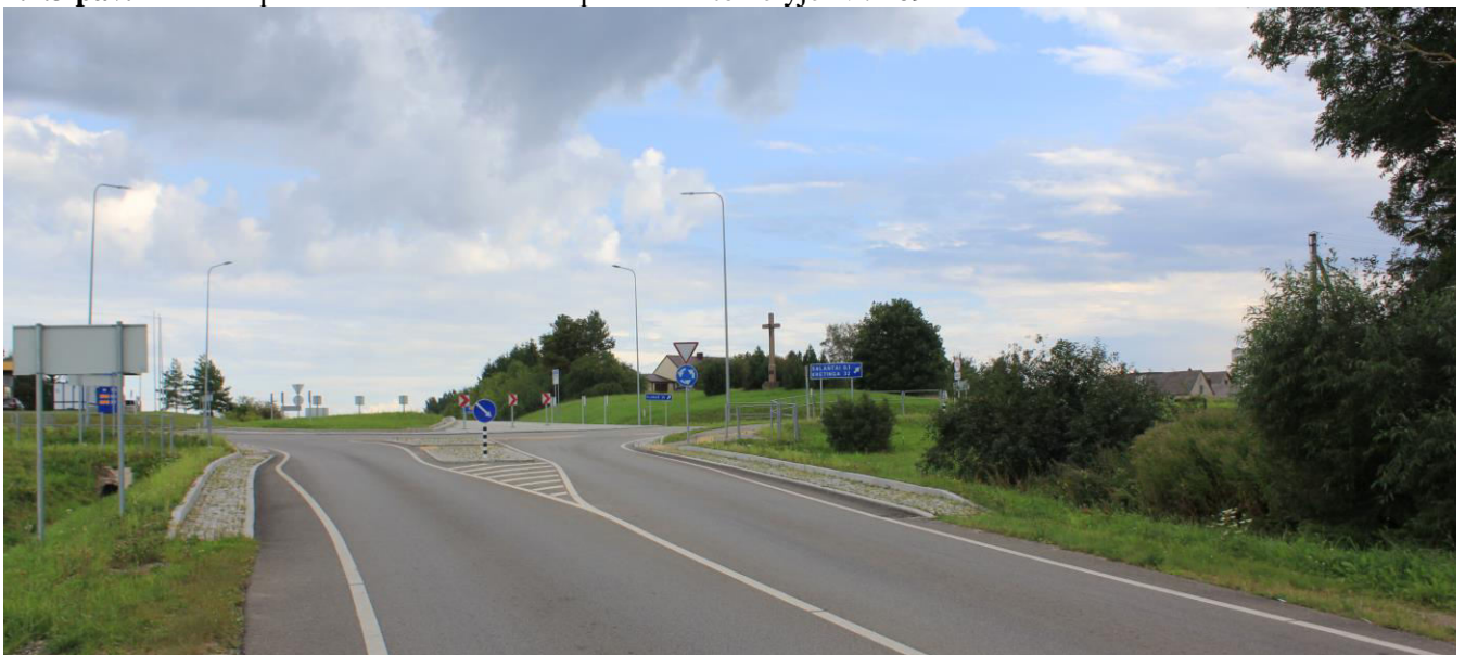
1.1.4 pav. Krašto kelias Nr. 169 ties sankryža su Laivių gatve (krašto keliu Nr. 226)
