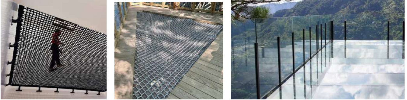
(Patyriminių elementų pavyzdžiai: tinklas ir stiklinė viršutinė apžvalgos aikštelės dalis)
