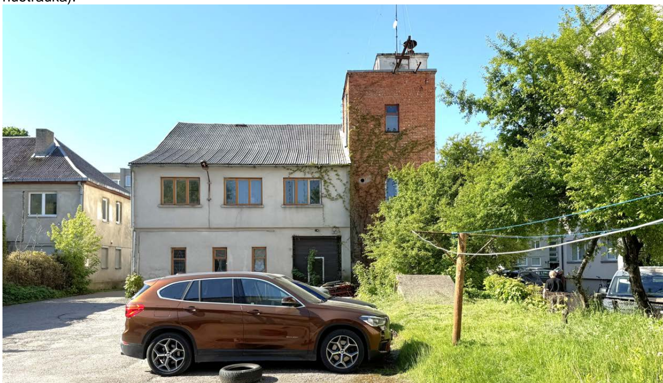
Esamos situacijos fotofiksacija stovint vidiniame kieme ir žiūrint į pastatą (2025m. nuotrauka). Matoma originali bokšto raudonų plytų apdaila .
