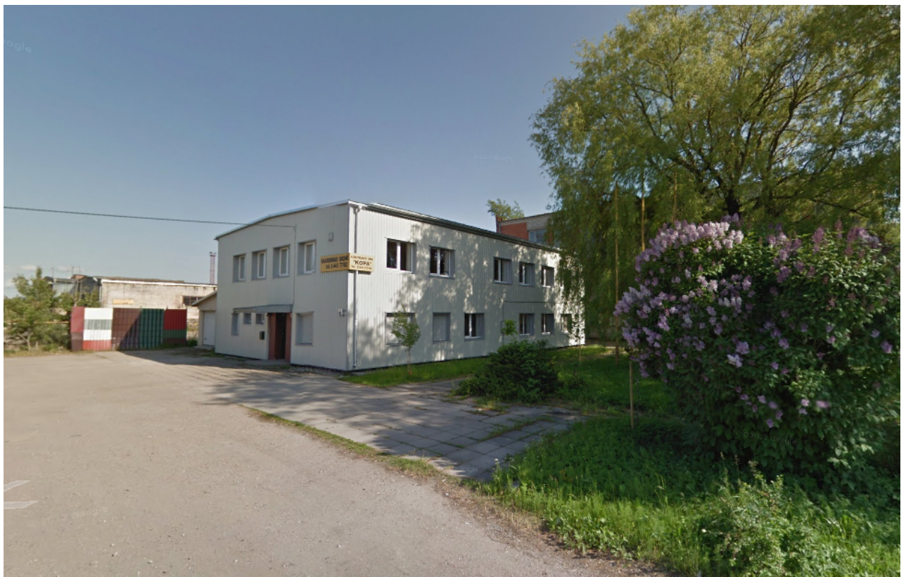
Administracinės paskirties pastatas, kuriame atliekamas kapitalinis remontas iš šiaurės vakarų pusės.
