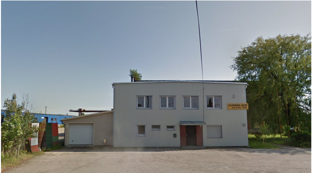
Administracinės paskirties pastatas, kuriame atliekamas kapitalinis remontas iš šiaurinės pusės.
