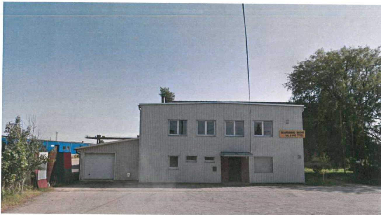
Administracinės paskirties pastatas, kuriame atliekamas kapitalinis remontas iš šiaurinės pusės.
