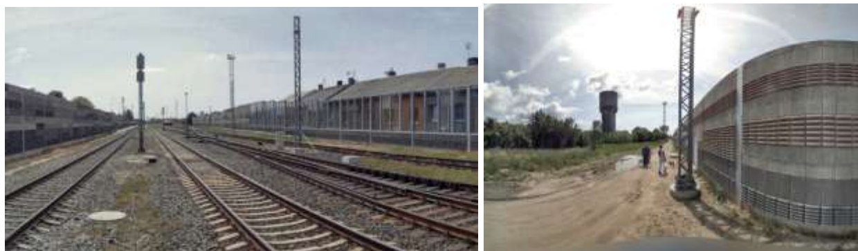
5 pav. Esami įbetonuoti elektrifikacijos atramų pamatai ir statomos atramos (sferinės nuotraukos)
