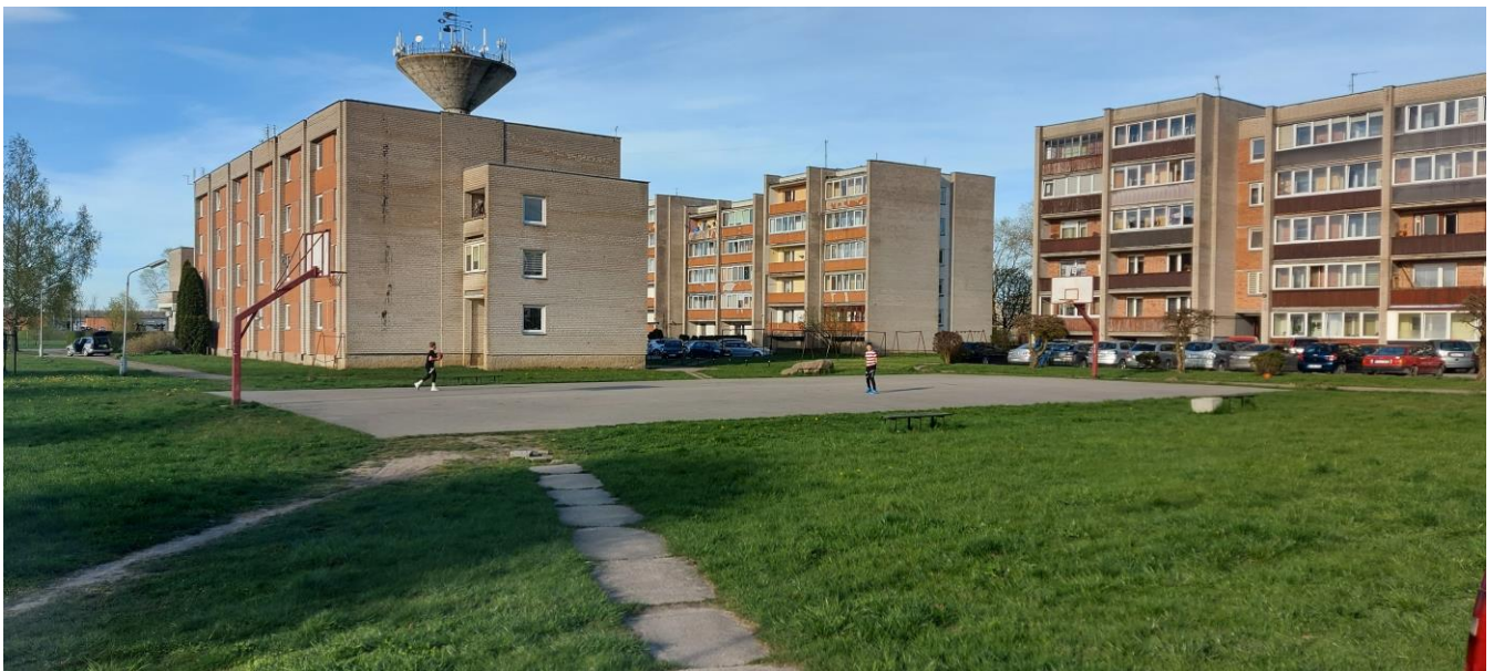
4 pav. Sporto žaidimų aikštelė planuojamoje teritorijoje, ties pastatais Melioratorių g. 79, Savanorių g. 60. Poilsio ir žaidimų erdvė pilnai neįrengta, trūksta takų, suolų, apželdinimo.
