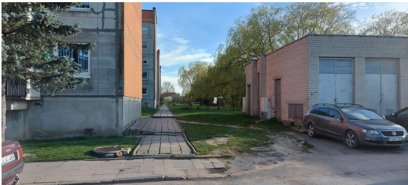
5 pav. Planuojamos teritorijos esama infrastruktūra susidėvėjusi, reikalingas pėsčiųjų takų, važiuojamosios dalies atnaujinimas.
