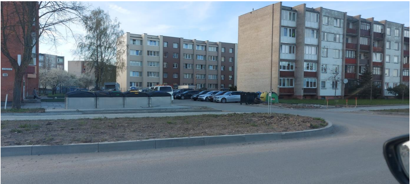
4 pav. Planuojamos teritorijos vaizdas nuo Vytauto gatvės, ties pirmu įvažiavimu į teritoriją
