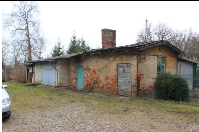
10. Klaipėdos g. 76. Kiemas su priklausiniais.
