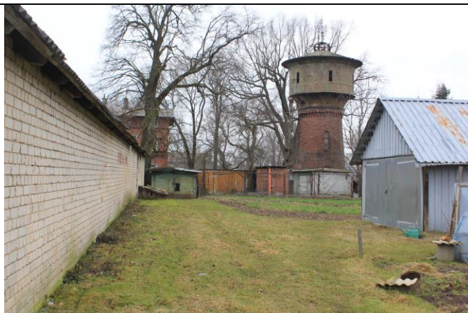
16. Buv. Bajorų geležinkelio stoties vandens bokštas.
