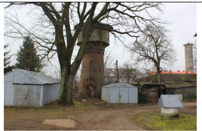
28. Vandens bokštas (Klaipėdos g. 68A). Nuo geležinkelio pusės.
