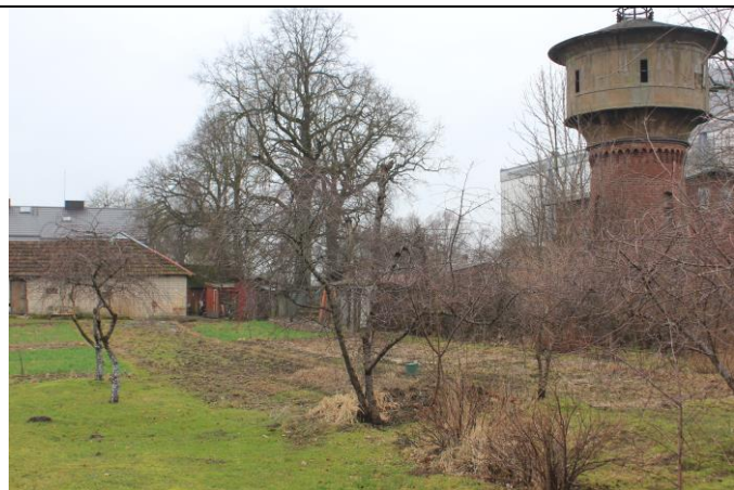
15. Buv. Bajorų geležinkelio stoties vandens bokštas.
