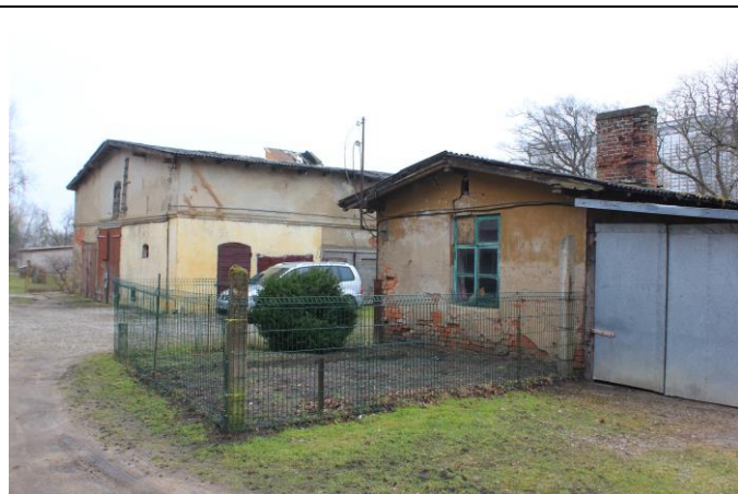
8. Klaipėdos g. 76. Kiemas su priklausiniais.
