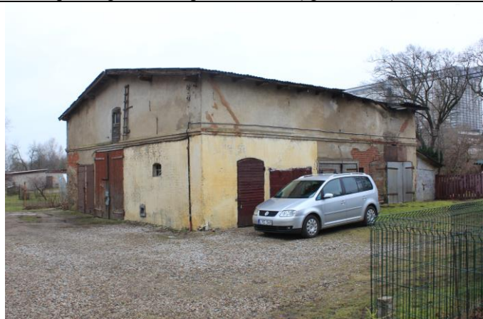
9. Klaipėdos g. 76. Kiemas su priklausiniais.
