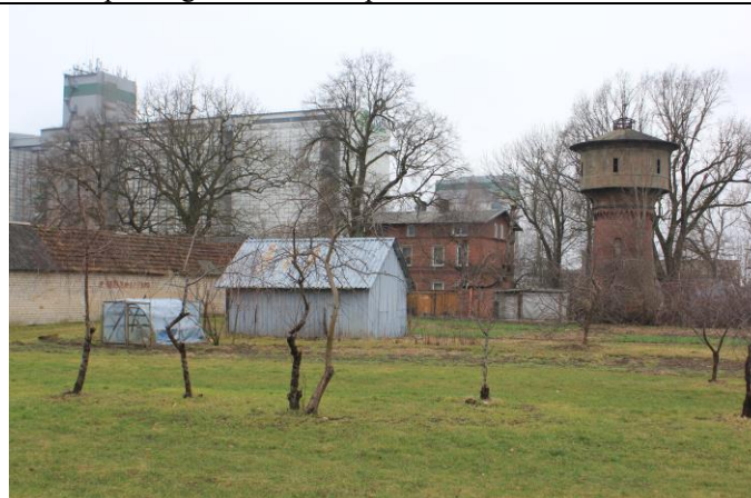
14. Buv. Bajorų gelež. st. vaizdas nuo Klaipėdos gatvės pusės.
