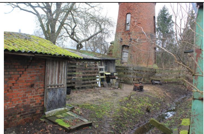
24. Vandens kanalas už Klaipėdos g. 70 ir 72 kiemo.
