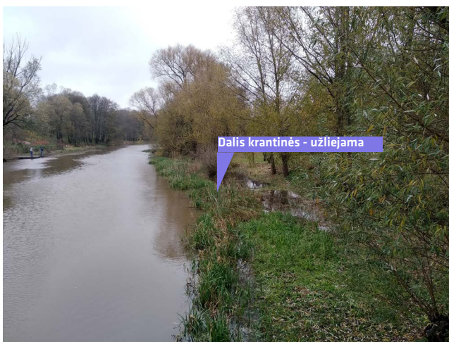
Kairioji krantinė. Vaizdas nuo pėsčiųjų tilto
