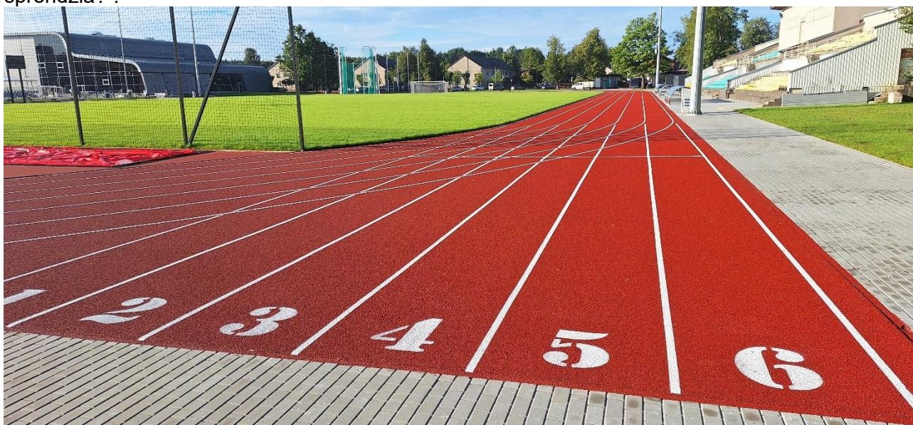
4 pav. Kretingos Šaulių stadionas po rekonstrukcijos darbų
