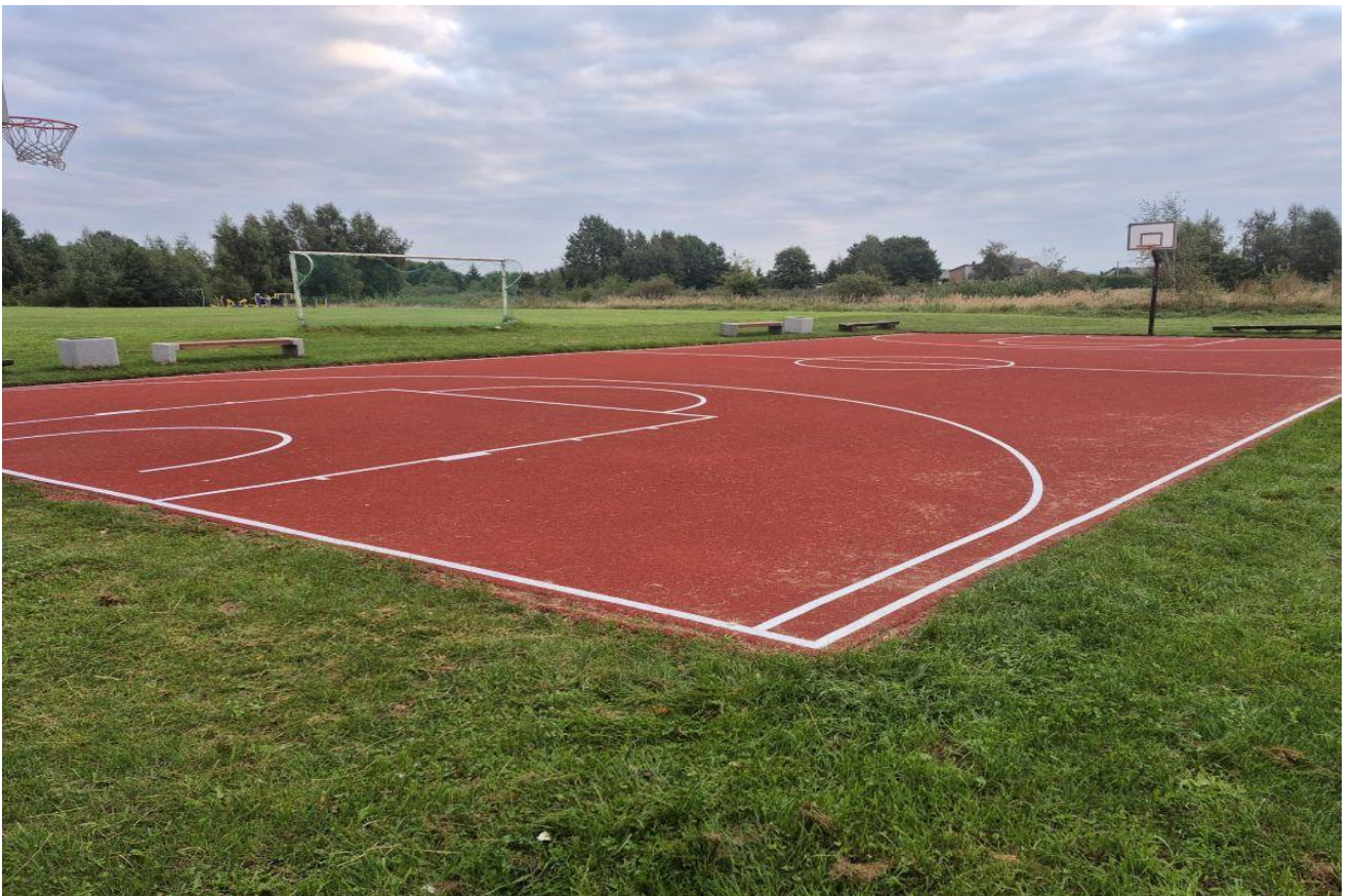
31 pav. Atnaujintas stadionas Kurmaičių kaime
