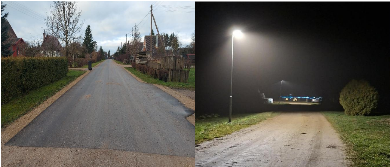
24 pav. Asfalto dangos įrengimas Žvainių km., įrengtas apšvietimas Juodupėnų km.
