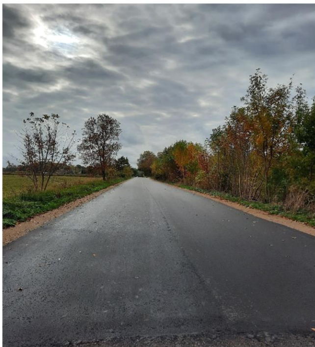
Atnaujinta asfalto danga dalyje kelio Kurmaičiai- Tūbausiai.
