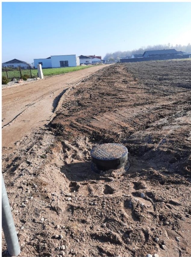
Įrengta lietaus nuotekų surinkimo sistema Dvaro Ganyklų g. Padvarių k.
