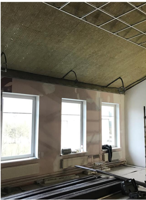
Mokslo paskirties pastato, Mokyklos g. 4, Vydmantų k., remonto darbai
