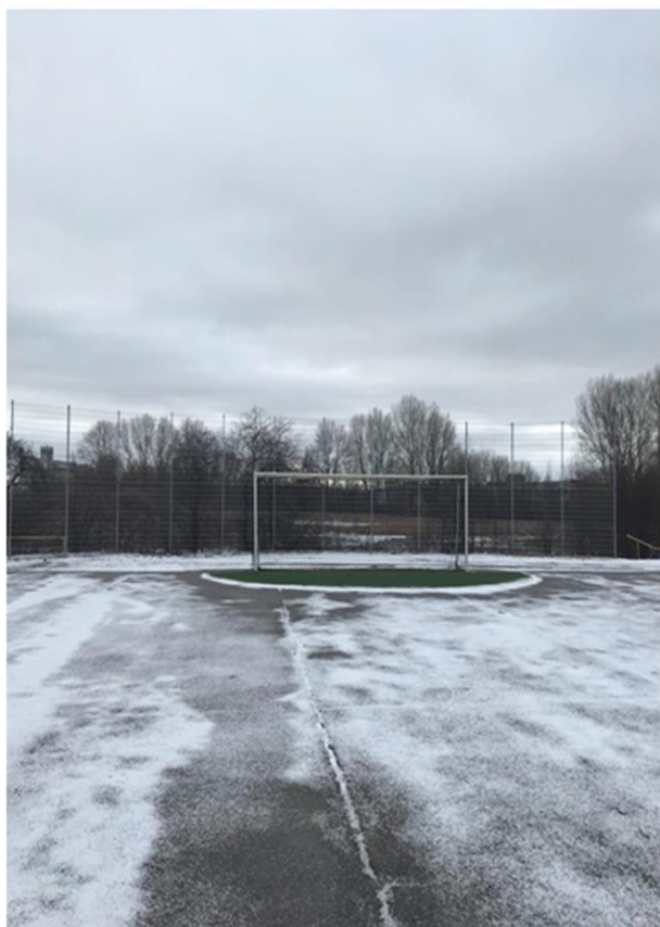
Motobolo aikštės apsauginių atitvarų (kamuolių gaudyklių) įrengimo darbai
