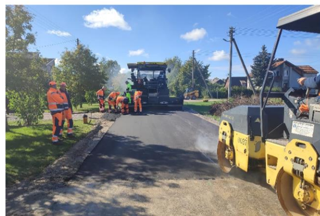
Birutės gatvės ištisinės asfalto dangos atnaujinimas
